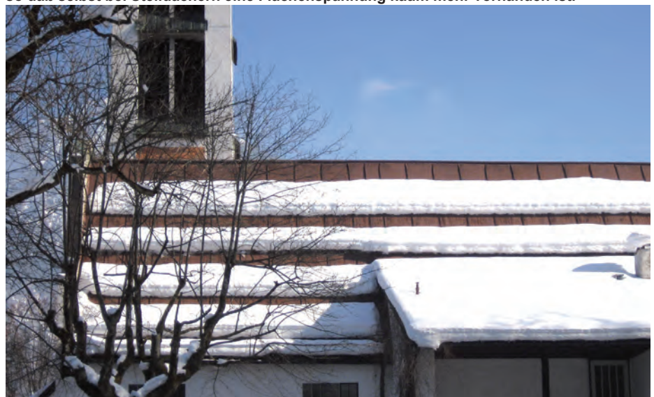
Bild 6: Durch flächenmäßig verteilte Rohre bilden sich einzelne Schneefelder, so daß selbst bei Steildächern eine Flächenspannung kaum mehr vorhanden ist.
