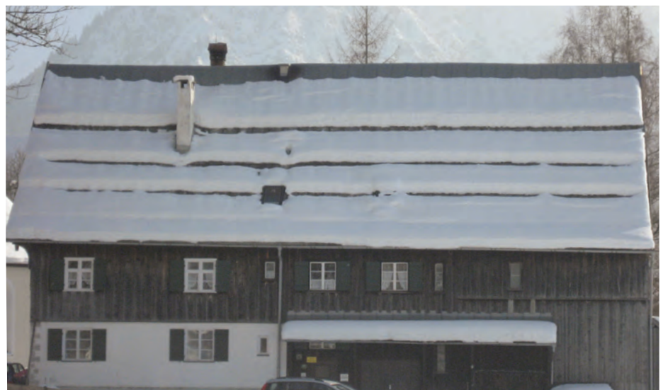
Bild 5: Gerade in Höhenlagen, wo eine große Gewichtsbelastung bei entsprechenden Schneehöhen entsteht, muss auf die strikte Einhaltung des Haftabstandes geachtet werden.
