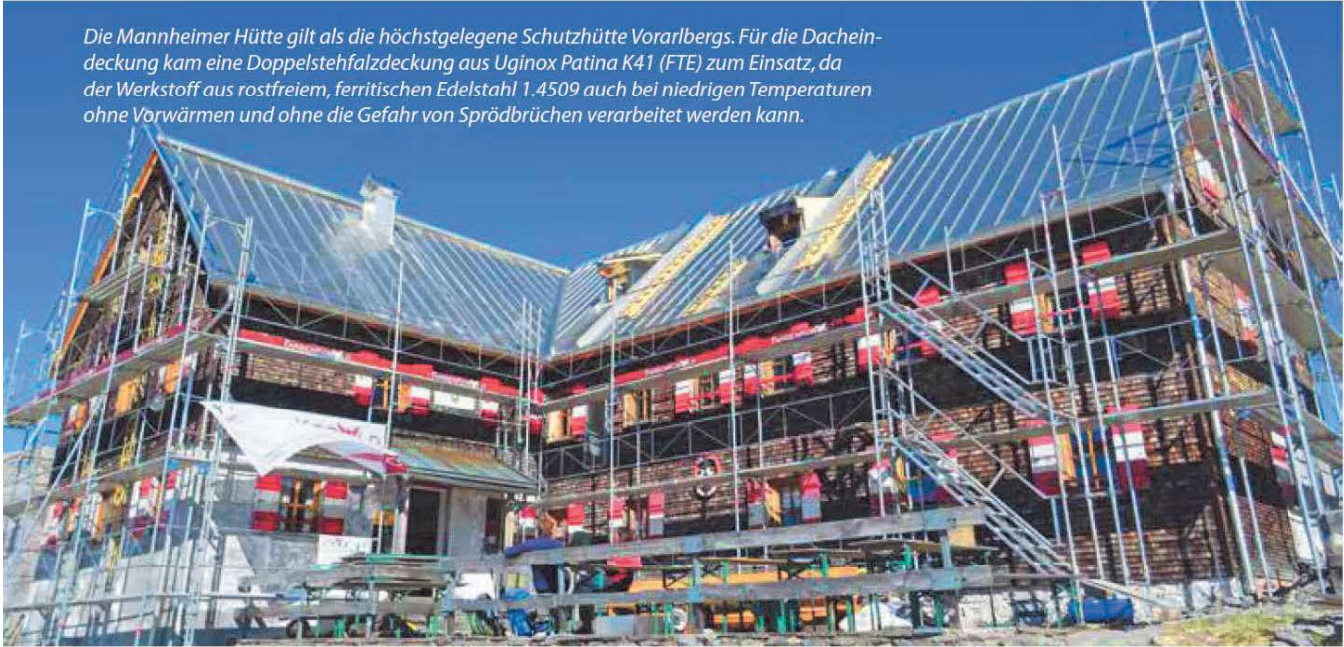
Fotos: © Küng Spengler & Dachdecker GmbH (2)
